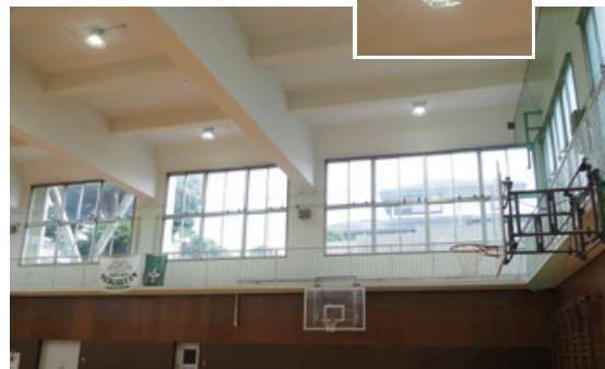
体育館照明LED化（省エネルギー化）
