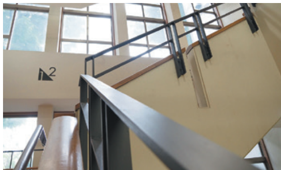
本館中央階段手摺増設（安全対策）
