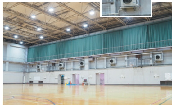
体育館エアコン設置（教育環境の整備）
