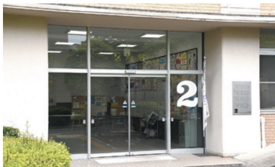
2号館自動扉設置（バリアフリー化）
