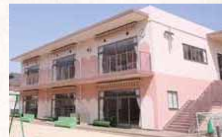
【聖学院幼稚園(園舎)】 2013年竣工
